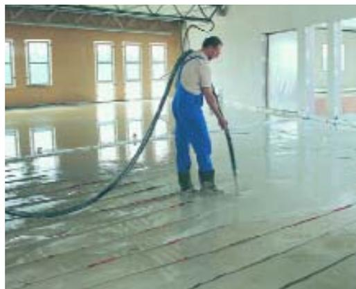
Нанесение наливного монолитного пола на систему подогрева пола
