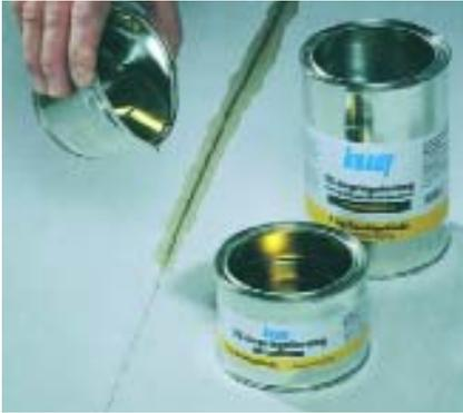
Заливка трещин эпоксидной смолой
