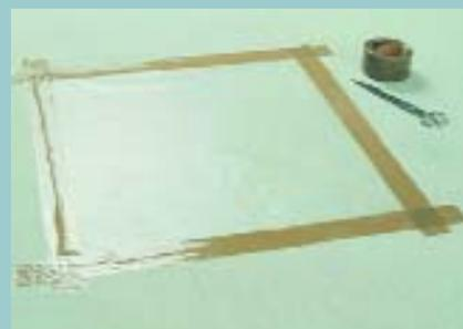
Проверка степени высыхания при помощи пленки на полах с подогревом
