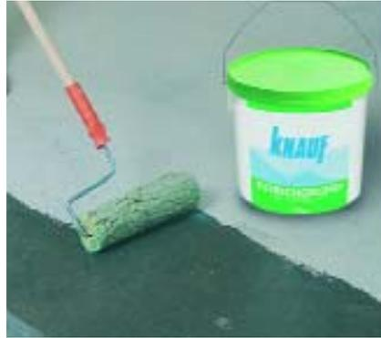
Нанесение грунтовки для монолитных полов Кнауф
