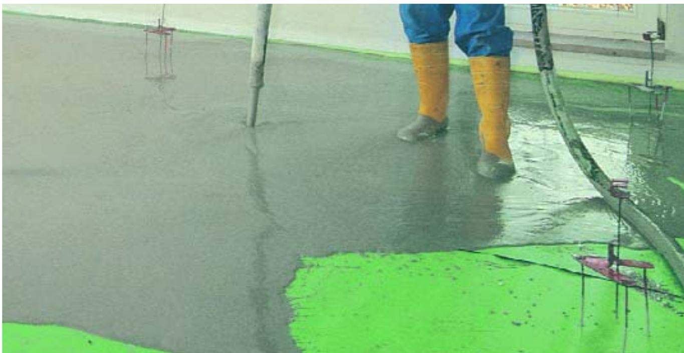
Устройство наливного пола на разделительном слое
