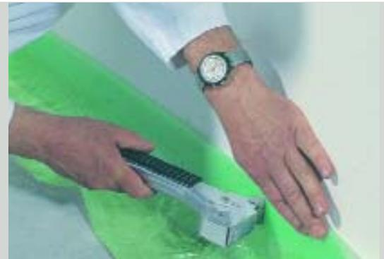
Установить кромочную ленту (в т.ч. на трубах, держателях нагревателей), не закрепляя по высоте наливного монолитного пола
