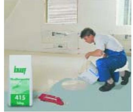
Шпаклевание монолитного пола с помощью Кнауф Нивелиршпахтель 415
